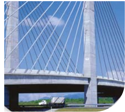
Utilización de Cordones Atirantados en la Carretera Inmigrantes - SP
